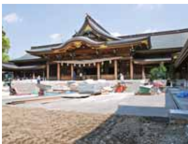
石張り工事風景
