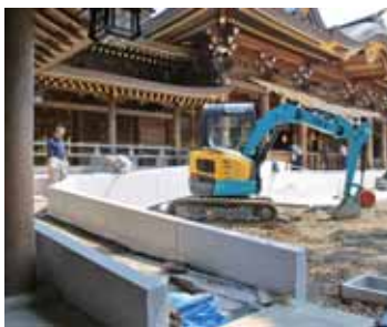
新設されるスロープ
