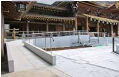
◀ 新設スロープ
